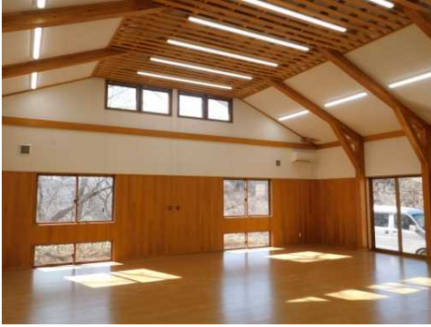
研修室の腰壁（スギ小幅板を使用）
