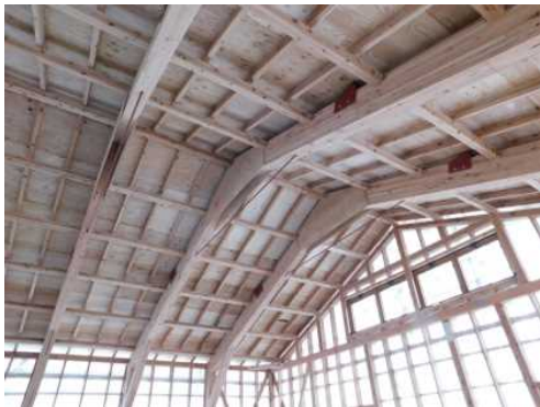
小屋組方式による天井部
