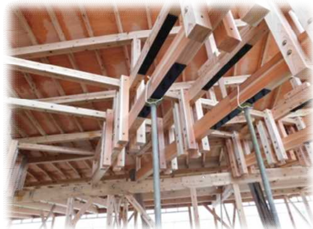
組立梁の施工状況
