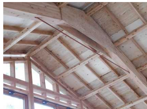
部材を鉄筋にすることで大空間を創出
